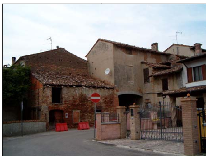
11. Edifici popolari e sottopasso su piazza Draghella
